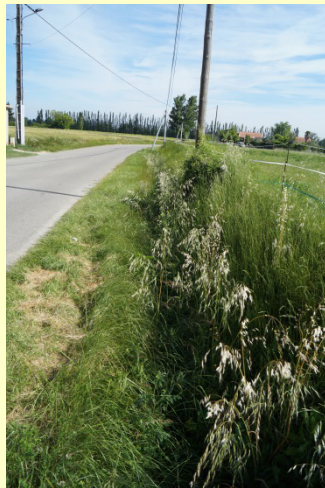
C: Fossé de collecte des eaux pluviales
